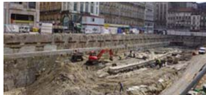
Le chantier en cours. © Urban.brussels
